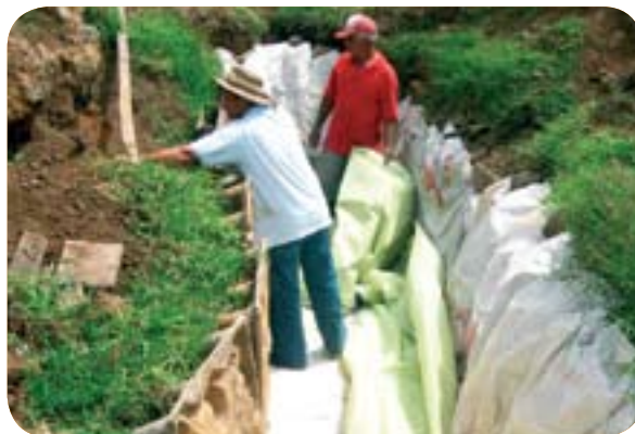
Preparación de la fosa para instalación del biodigestor.
