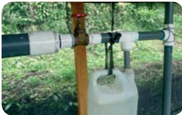
Sello de agua con recipiente plástico para controlar los excesos de producción de biogás.
