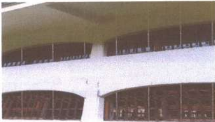
F1: Fachada principal
