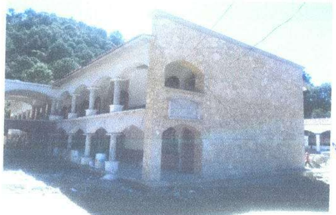
CONSTRUCCION DE 2 EDIFICIO C
