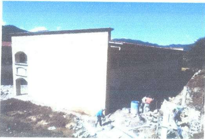
CONSTRUCCION DE 2 EDIFICIO B
