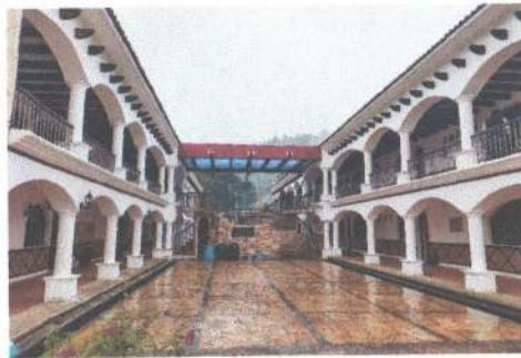
F1: Fachada principal
