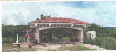
F1: Fachada principal
